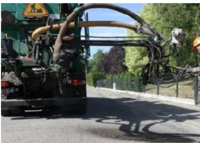
Ce procédé utilisé pour les réparations localisées de la chaussée (nids-de-poule, déformations de rives, etc.) consiste à appliquer le gravier siliceux enrobé dans son intégralité d'émulsion. Une microcentrale réalise le mélange émulsion/gravillons et le projette dans le trou de chaussée à réparer.
