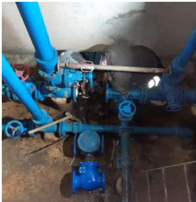
Opération changement de clapet au réservoir des Gillots.
