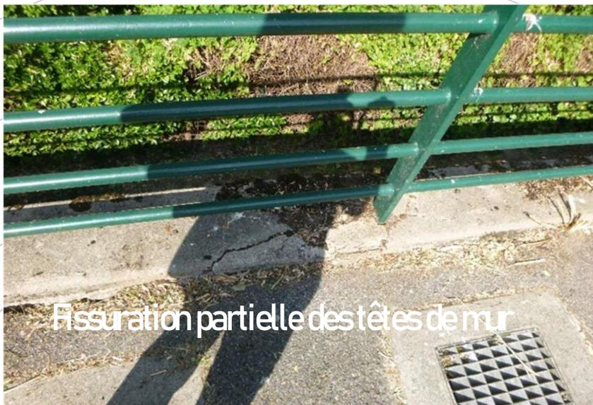
Fissuration partielle des têtes de mur
