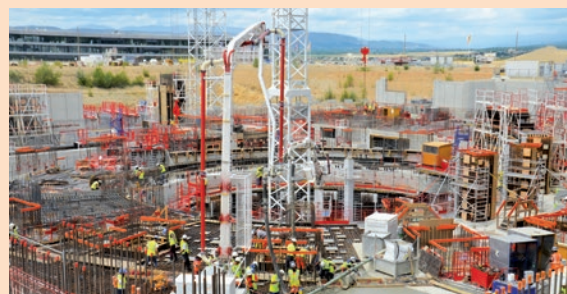
Les équipes de Vinci-Ferrovial-Razel se relaient de 6h à 22 h sur la zone de construction du tokamak.
