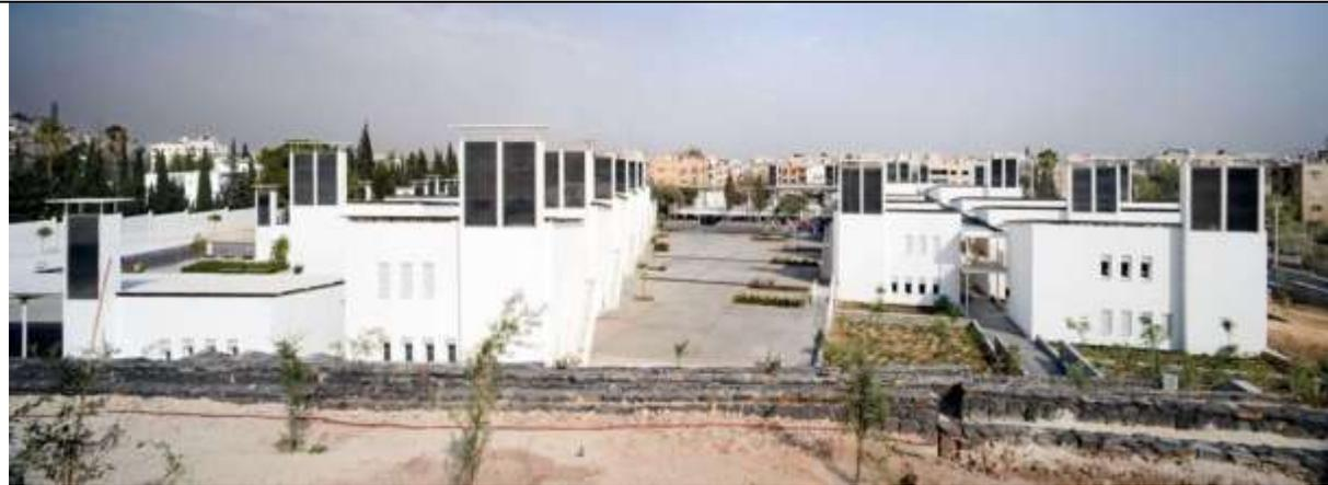
L'école Française de Damas, en Syrie, conçue par les Ateliers Lion en 2008, est une bonne illustration de l'usage qu'il peut être fait des techniques traditionnelles pour limiter les consommations dues au refroidissement et au chauffage. D'une superficie de 10.000m<sup>2</sup>, elle abrite plus de 900 élèves. Différentes techniques ont été associées pour créer un microclimat optimal de manière passive:
