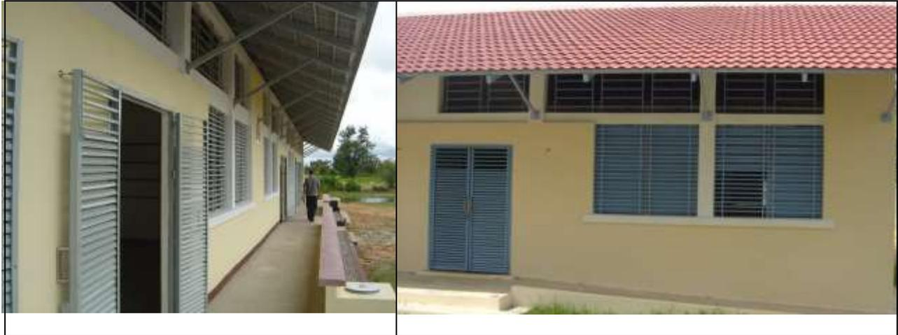
**Figure 26:** Exemple de ventilation naturelle maximisée via portes et fenêtres
