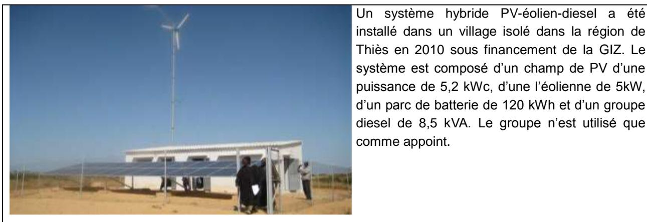
**Figure 47:** Exemple d'installation hybride au Sénégal
