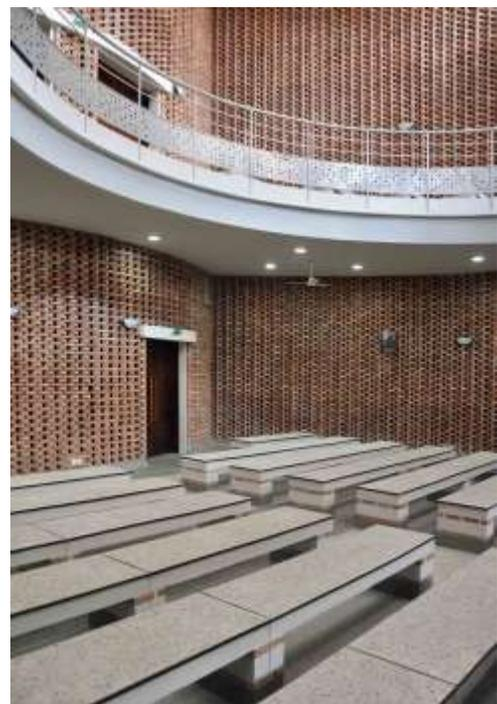
Parallèlement, la ventilation naturelle a été favorisée grâce à la disposition réfléchie d'un ensemble de fenêtres équipées de vantelles métalliques. Ces vantelles, au même titre que le bardage métallique qui recouvre la façade, contribuent également à la limitation des apports thermiques du soleil. Enfin, une étude acoustique poussée a conduit à la mise en œuvre d'un appareillage spécifique des briques, comme piège à son (voir photo intérieure).
