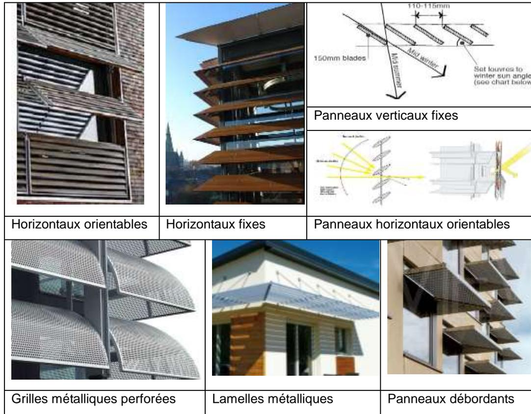
**Figure 18:** Différents modèles de brise-soleils
