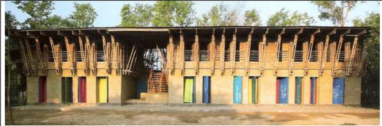
L'école primaire de Rudrapur au Bangladesh a été conçue par les architectes A. Heringer et E. Rosway en 2006 pour le compte d'une ONG. Elle utilise essentiellement deux techniques passives ; d'une part, la masse thermique de la terre crue pour le rez-de-chaussée et, d'autre part, la ventilation naturelle au travers d'une structure légère en bambou pour l'étage.
