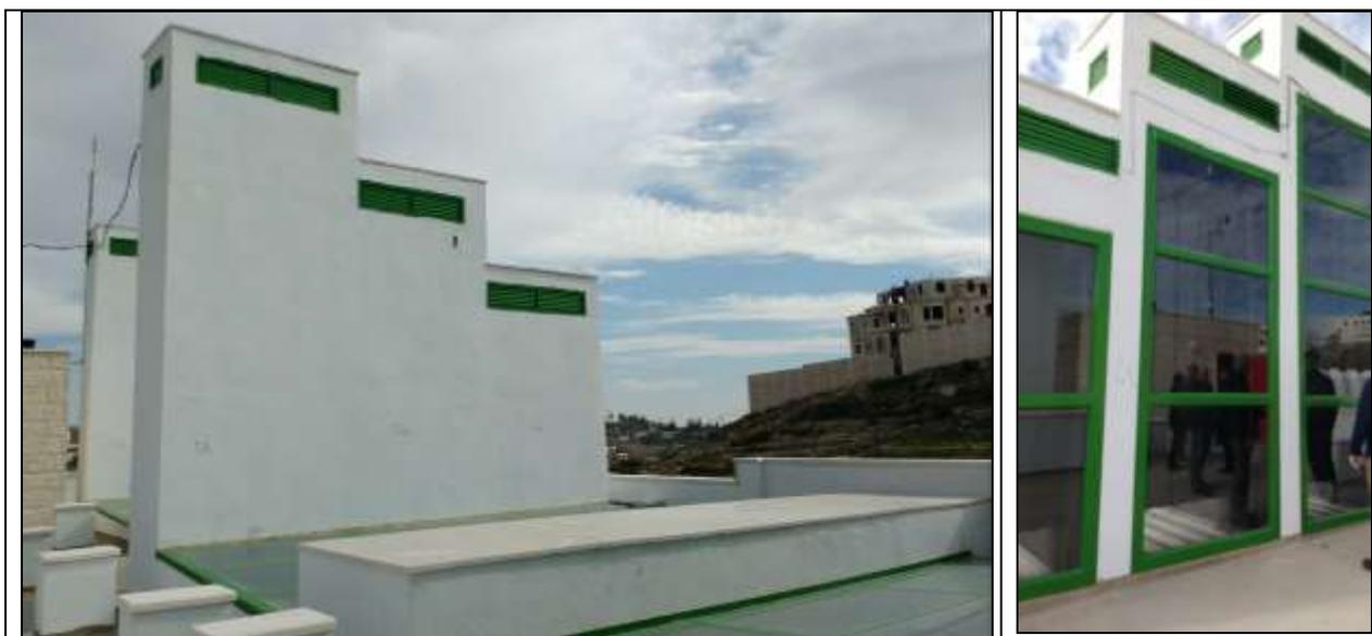
Différentes technologies passives ont été expérimentées dans cette école pilote, dont des cheminées solaires qui disposent d'une partie verticale et d'une partie horizontale vitrée.
