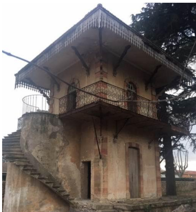
Le « Chalet » la veille de sa démolition
