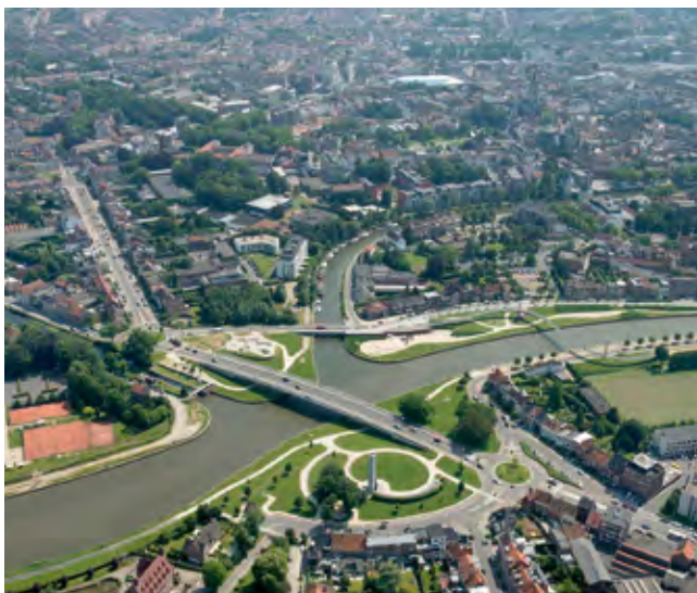
Aménagements de la traversée de Courtrai par la Lys (source Leiedal )
