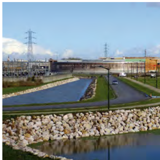
Lagunage à proximité du centre de valorisation organique de Sequedin (source : MEL )
