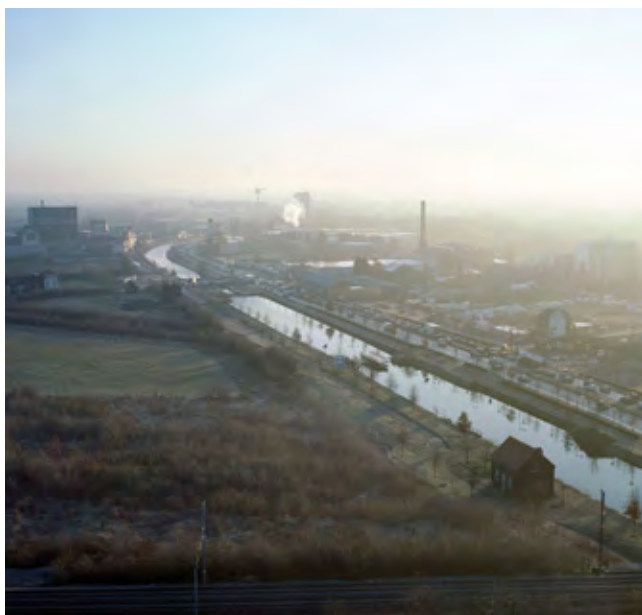
Le canal de Roubaix et le site de l'Union en 2010 (source G. Bonnel/ADULM)
