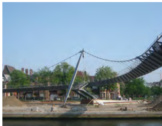
Pont de franchissement sur la Lys à Kortrijk (source : ADULM/TB)
