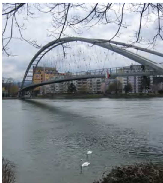
Pont de franchissement sur le Rhin entre Saint Louis et Weil (source : ADULM/TB)
