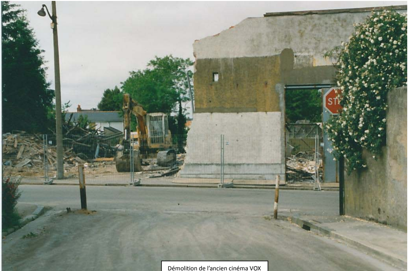
Démolition de l'ancien cinéma VOX
