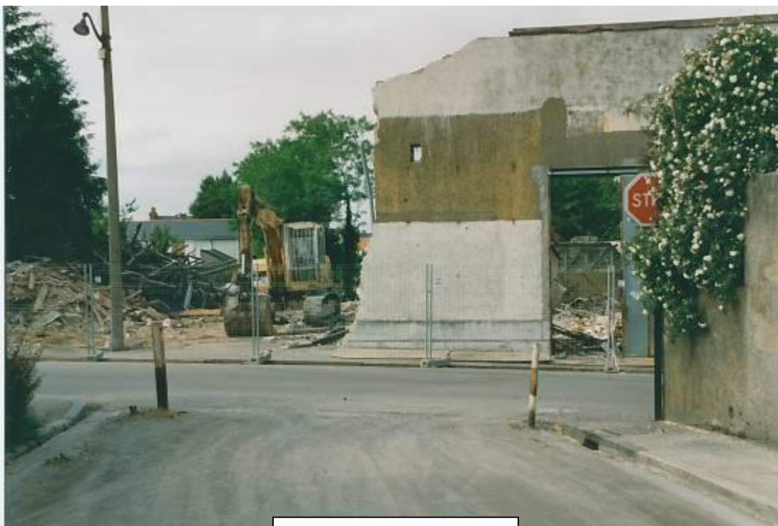
Démolition de l'ancien cinéma VOX
