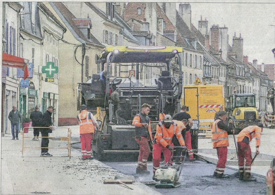
L'application des enrobés de la Grande-Rue. Photo LBP/A. G.
