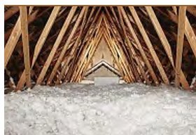
Nouveau en 2019 : Isolation des combles perdus à 1€ pour TOUS Les Eco Isolateurs
