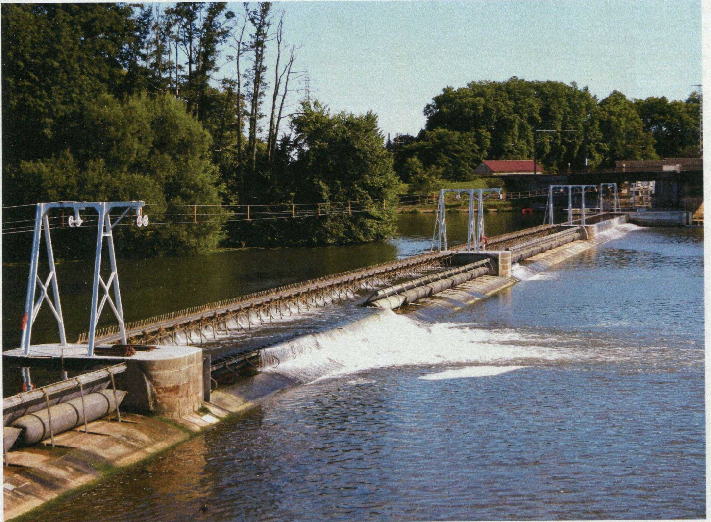
Auxonne - L'ancien et le nouveau barrage
