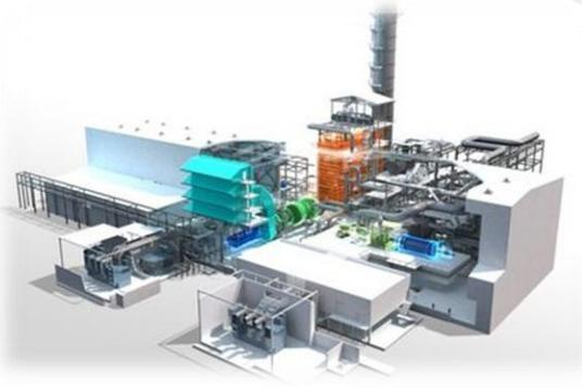
La production annuelle d'une centrale de 555 MW de puissance avec une production à plein charge 24h/24 et une consommation de 1,9 Milliards de NM<sup>3</sup> de Gaz Naturel (GN)
