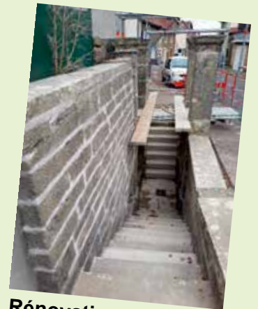
Rénovation en cours de la Fontaine Grande Rue
