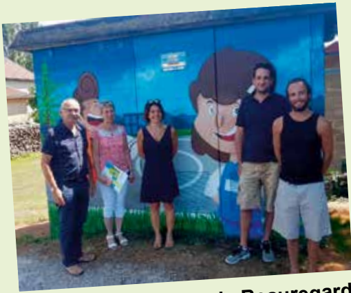
Transformateur rue de Beauregard
