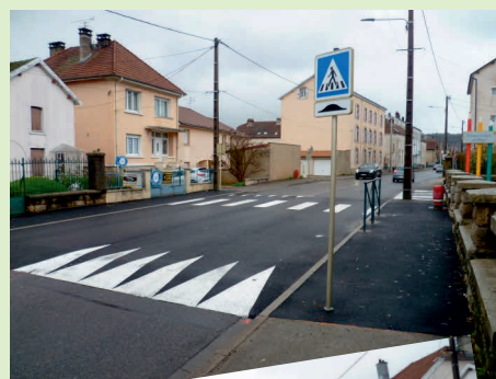
Aménagement rue Parmantier
