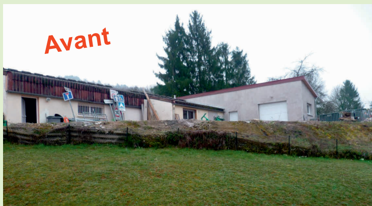
Mur école de la Flandrière
