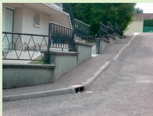
Bordures de trottoirs Parc de la Paule
