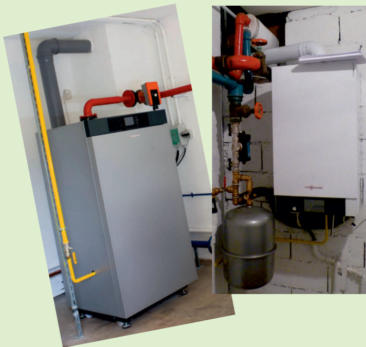
Pose de chaudières neuves dans les écoles de Pont, Longeville et de la Flandrière et maison des associations
