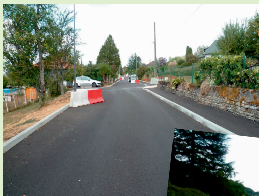
Aménagement d'une partie de la rue de la Fontenotte
