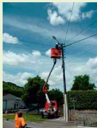
Pose d'ampoules LED
