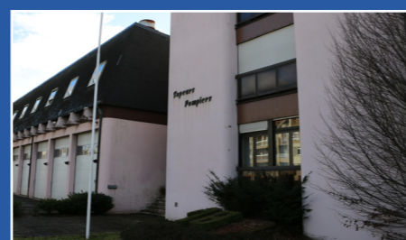
Caserne des sapeurs-pompiers de Hagondange
