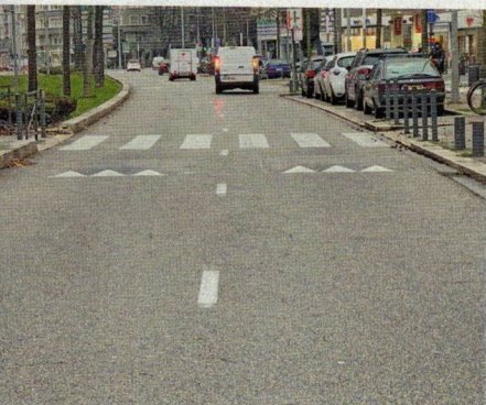
Si l'aménagement n'est pas assez visible, il faut renforcer la signalisation.
