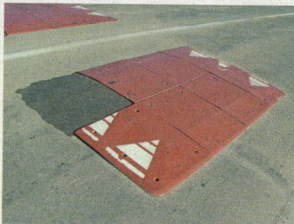
Les coussins en caoutchouc deviennent glissants et se dégradent rapidement.
