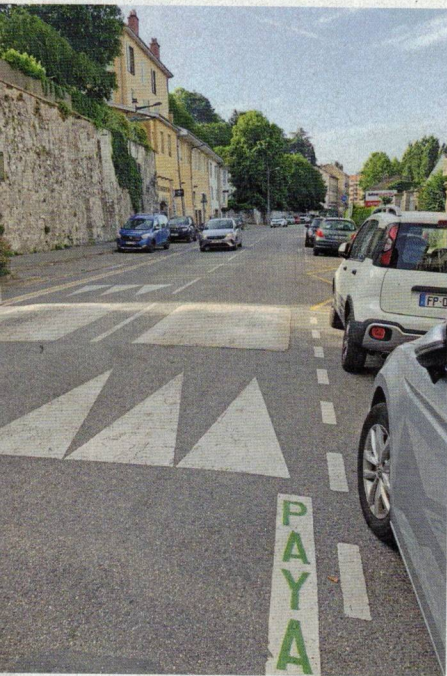
Exemple d'un espace insuffisant entre le coussin et le stationnement.
