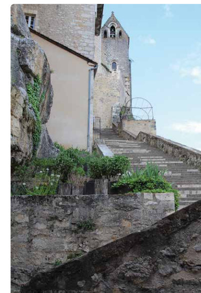
● Le grand escalier à ROCAMADOUR a été façonné à l'aide de maëllons de travertins mélangés à des maëllons calcaires.
