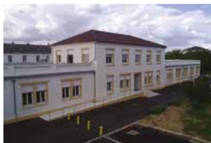
Le bâtiment du CERP'Air
