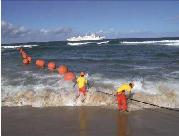
Pose d'un câble sous-marin par le navire câblé Chamarel. © Orange Marine
