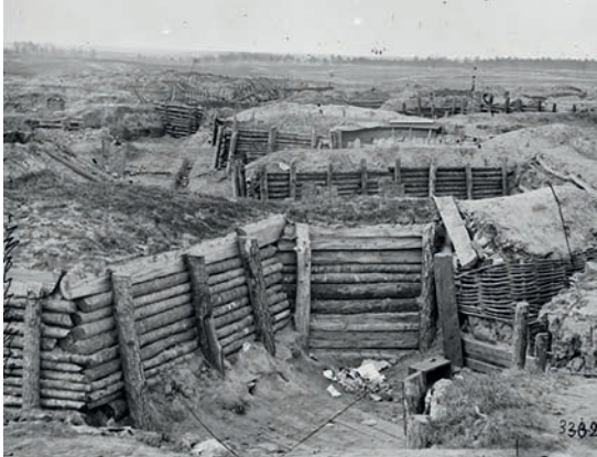
Réseau de tranchées construit dans la région de Petersburg, pendant la campagne de Virginie.
