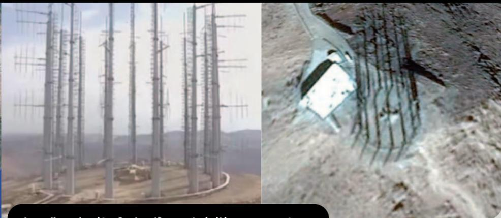
**Le radiogoniomètre Sepher (Cosmos) révélé par un reportage de l'agence FARS en septembre 2018. Les caractéristiques de ses antennes Log périodique permettent de suivre, selon les sources iraniennes, les émissions des véhicules extra-atmosphériques jusqu'à 2500 km d'altitude.**
