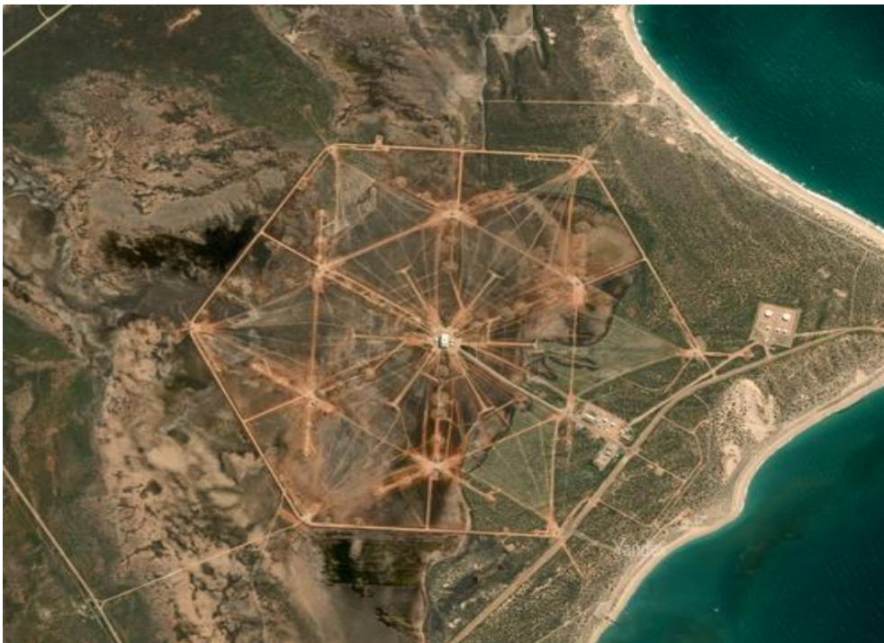
Fig. 3. Australie, puissant émetteur VLF (émetteur North West Cape (NWC) : Naval Communication Station Harold E. Holt) [45]
