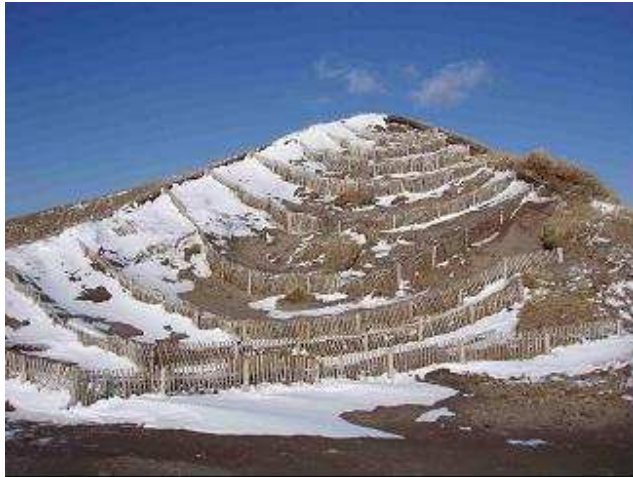
Restauration de dune par pose de ganivelles et plantations d'Oyat
