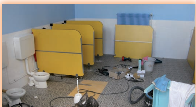
Les sanitaires pendant travaux
