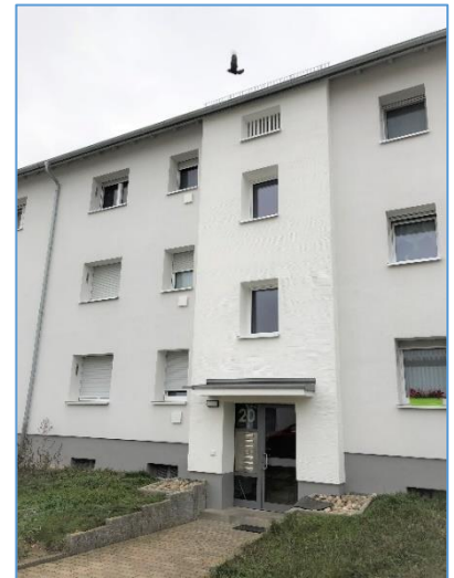
Energetische Sanierung Bundeswehrwohnanlage
