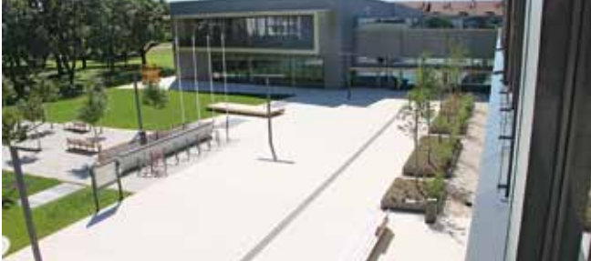
Abb. 10: „Angepasstes“ Rathaus Gilching (baulicher Überhitzungsschutz (außenliegende Verschattung), automatische nächtliche Querlüftung und Kühlung per Grundwasser)
