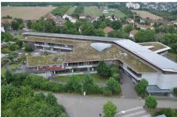
*Die ausgeprägte Dachbegrünung ist ein weiteres Element des nachhaltigen Bauens am Gymnasium Veitshöchheim. Dachbegrünungen haben im Sommer eine kühlende und im Winter eine dämmende Wirkung. Die Pflanzen filtern Staub aus der Luft und eliminieren Schadstoffe.*
