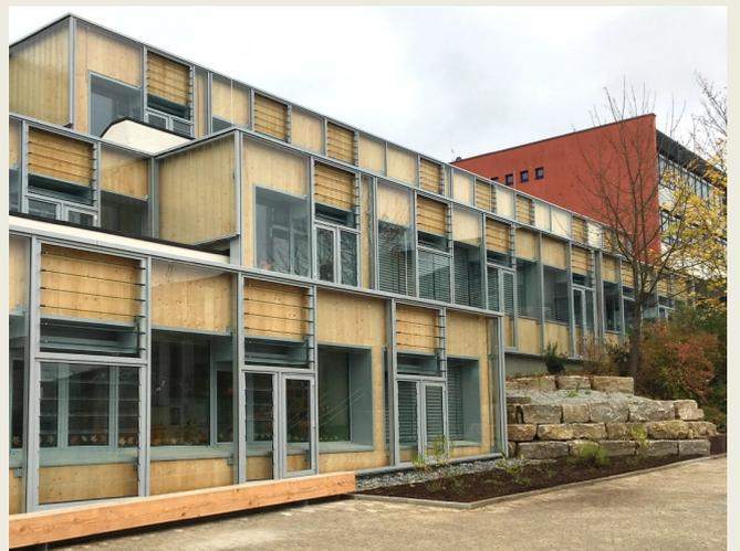
Innovativ und zukunftsweisend wird die **Fassade des 2. Bauabschnitts der Eichendorffschule** energetisch saniert und mit einem neuartigen Dämm- und Lüftungskonzept versehen. Dieses macht sich das Prinzip der thermischen Konvektion, die sogenannten Kaminwirkung zu eigen. Die Projektkosten betragen ca. 1,3 Millionen Euro.
