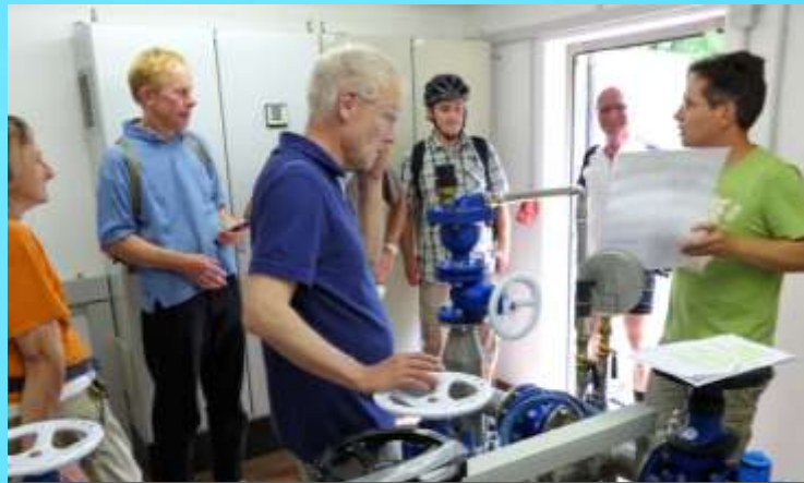
Veitshöchheim erfahren „Trinkwasser“
