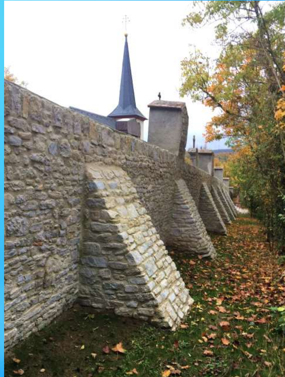
Sanierung und statische Sicherung durch Mauerpfeiler
