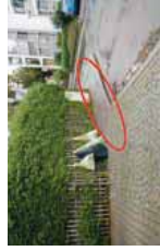
Engstelle knapp über 1 m mit Verschwenkung und Kleinsteinpflaster, welche die Barrierefreiheit einschränken
