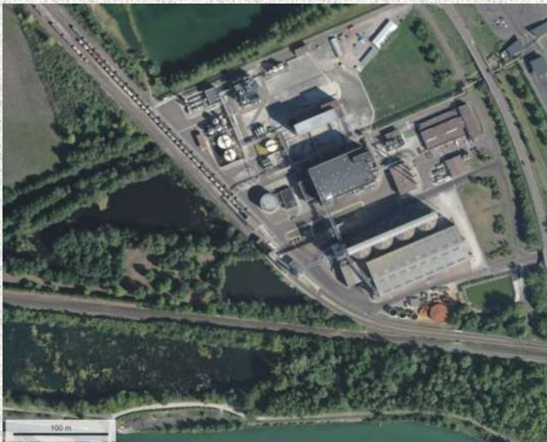
Illustration 4 : photographie aérienne du site de Soufflet relié à la voie ferrée (2019, Géoportail)
