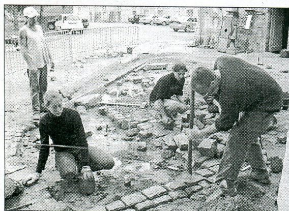
Pose de pavés, dans la cour attenante à la salle de corps de garde (photos Daniel Vachon)
