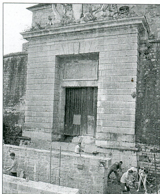
La deuxième pile du pont dormant a été mise à niveau
