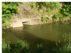
La sortie dans le contre-fossé
