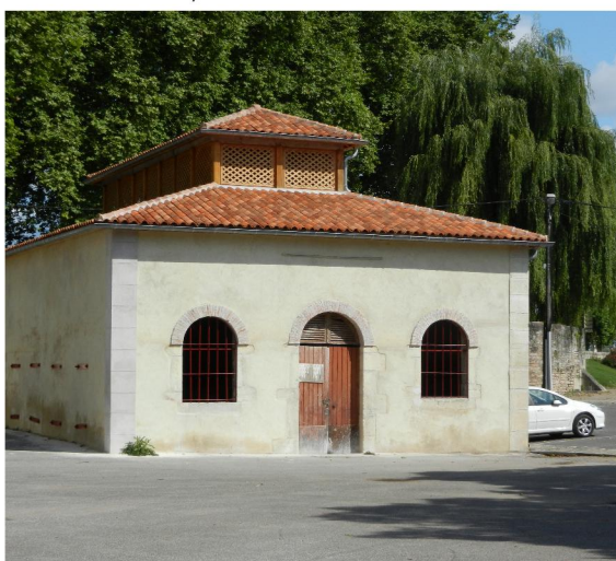
En 1842 la Ville transfère la Tuerie qui se trouvait rue Sennecey dans un Abattoir neuf, construit au dessus du cours de la Petite Saône qui évacue les déchets dans le contre-fossé du Château.
