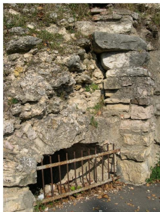
Entrée du souterrain
