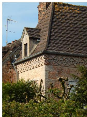
La brique ancienne n'est pas normalisée, sa taille dépend du moule. Celles que nous avons mesurées ont des dimensions d'environ 25 x 12/12,5 x 4 cm. Elles sont maçonnées à plat, de façon régulière, une ligne en panne-resse, une ligne en boutisse, sur la largeur d'une brique et demie, avec des joints à la chaux assez larges (Ph.1)
