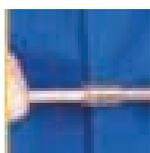
Emboîter le raccord sur le tube jusqu'en butée et vérifier que le tube est correctement inséré en tirant.
