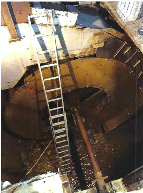
Au moulin de la Combelle (Ardèche), la roue par au-dessus de 4,50 m, sur une chute de 6 m pour 25 kW, dispose d'un rendement global de 50 %, compensé par une vitesse de rotation élevée. Image : Lilian Ranc
