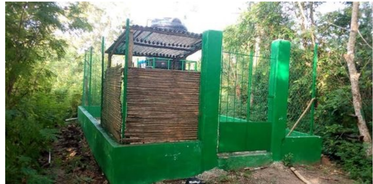
La station DICLORO de Vogankopé
