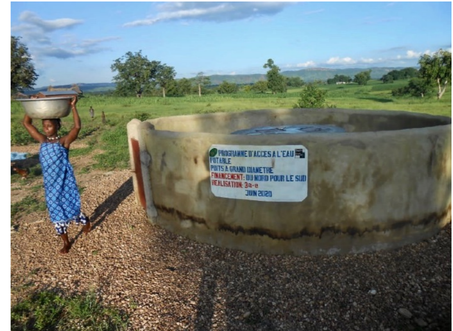
Puits busé de grand diamètre et aménagé
