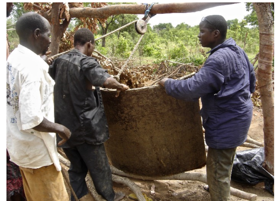
Mise en place des buses
