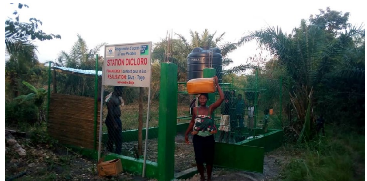
La station DICLORO de Gapé-Tsikale
