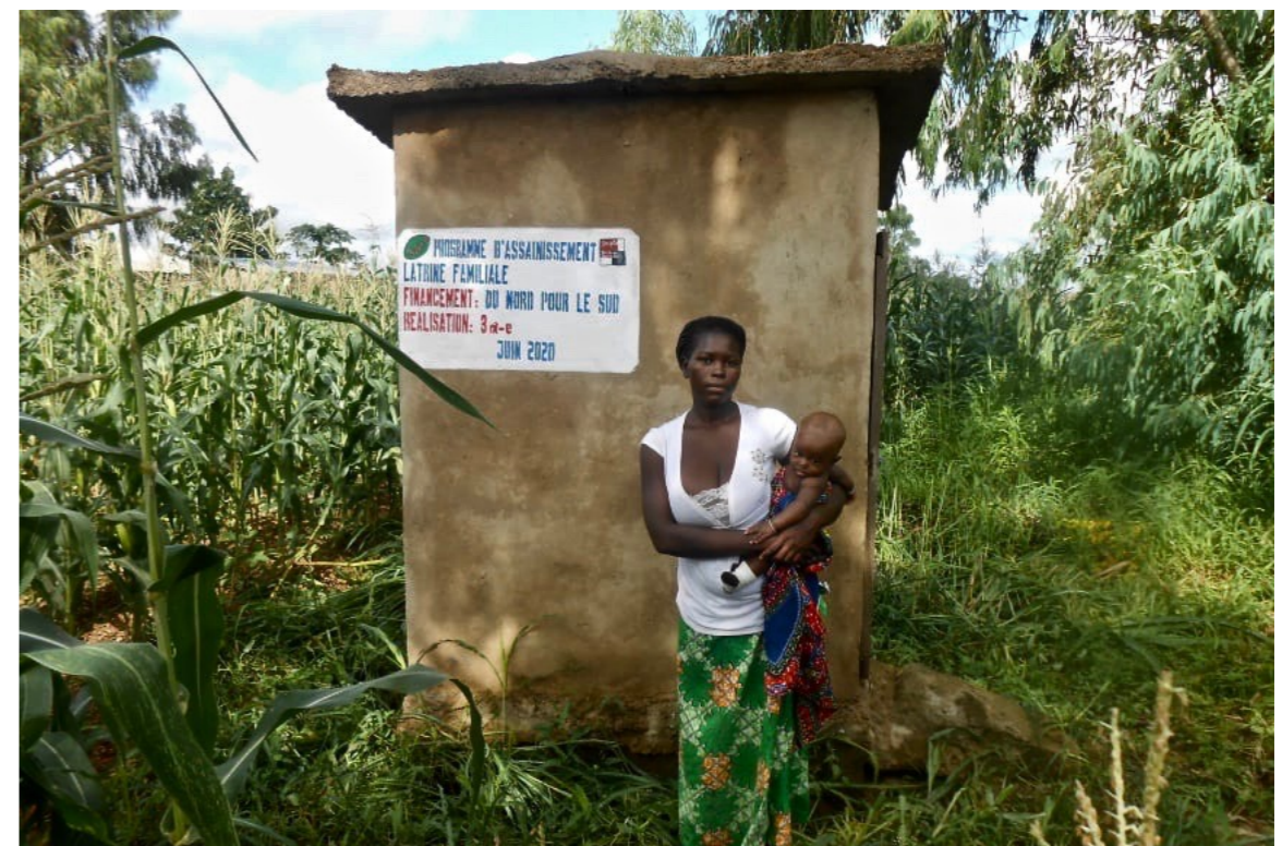
Latrine à fosse étanche
