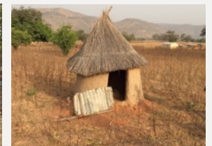
Assainissement: latrine familiale
