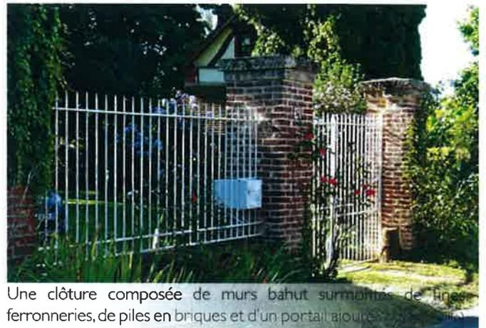
Une clôture composée de murs bahut surmontés de fines ferronneries, de piles en briques et d'un portail ajouré
