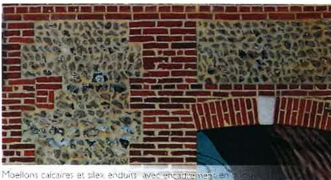
Moellons calcaires et silex enduits avec encadrement en brique (L'Écluse)
