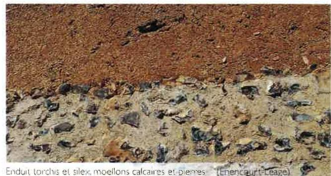
Enduit torchis et silex, moellons calcaires et pierres (Encauffry-Loage)
