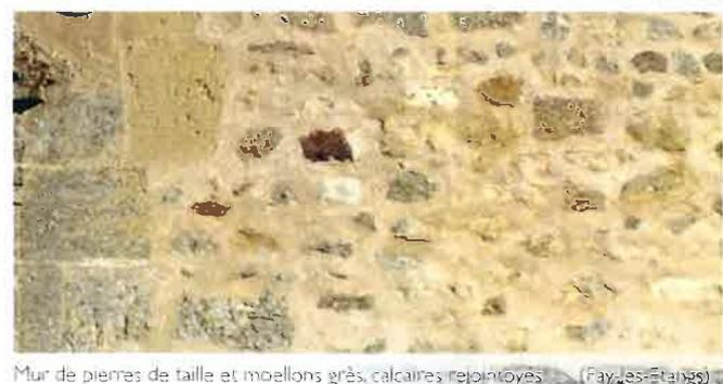
Mur de pierres de taille et moellons grès, calcaires rejointoyés (Fay-les-Étangs)
