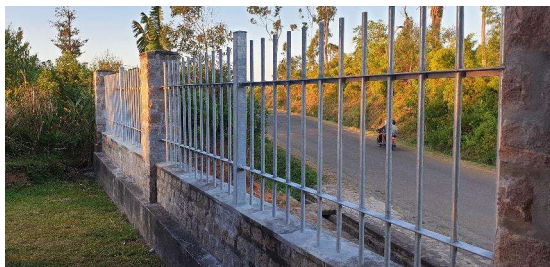
Août, montage des grilles sur site
