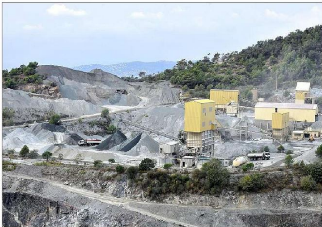
La carrière des Grands Caous actuellement. Ces installations seront démontées pour pouvoir creuser à leur emplacement et exploiter le porphyre.
