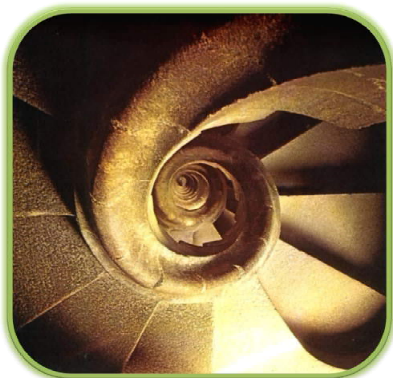
Escalier en colimaçon en pierre du clocher
