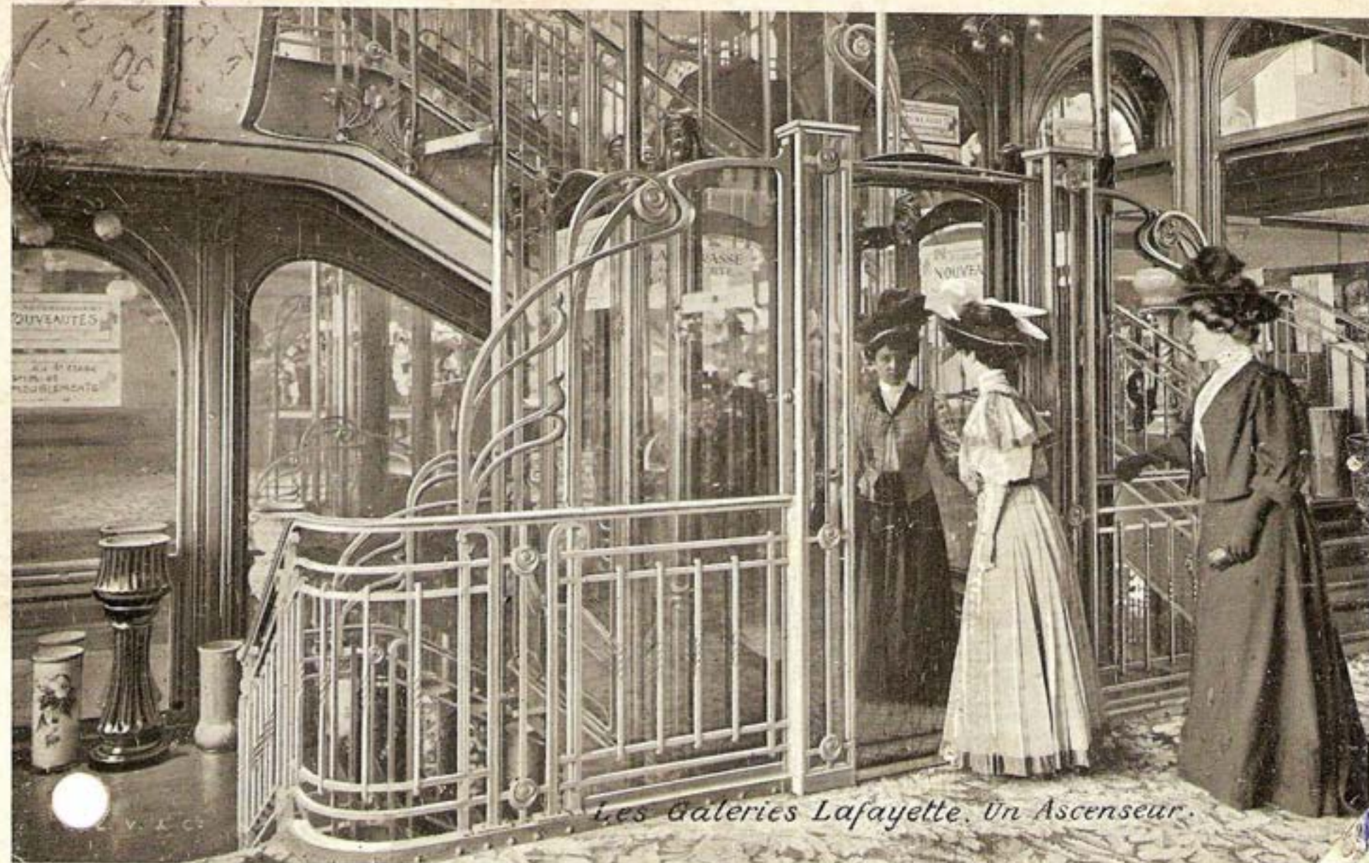
Galleries Lafayette, ascenseurs
