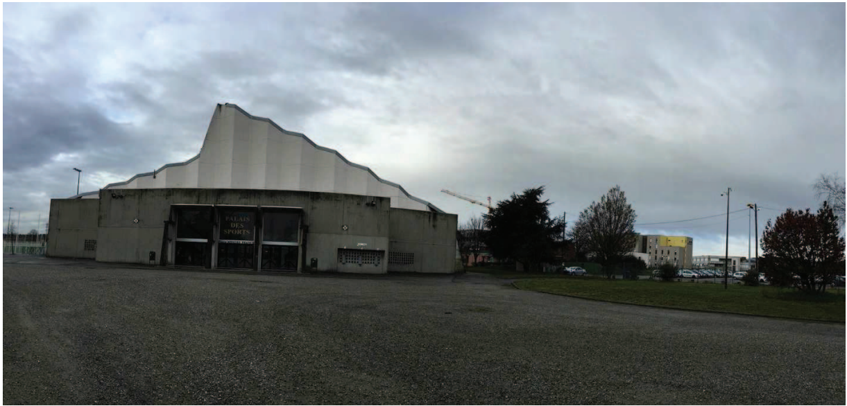
Entrée Principale du Palais des Sports Pierre Mendès France – avec Parking sur la droite
