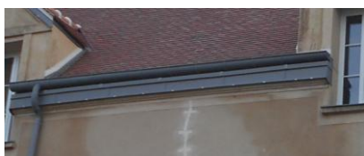
Corniche masquée par une bande en zinc
