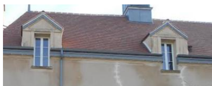
Descentes pluviales désormais visibles en façade sans dauphins en fonte au pied des descentes
