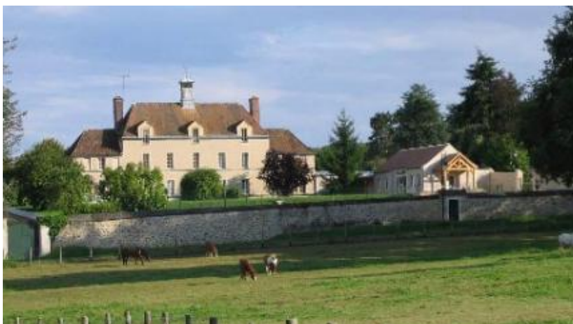
Le manoir avant la rénovation de sa toiture
