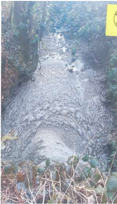
Constats du 25 février 2017 au niveau de la maison forestière [cf. pièce n°2.6-dossier d'assignation]
