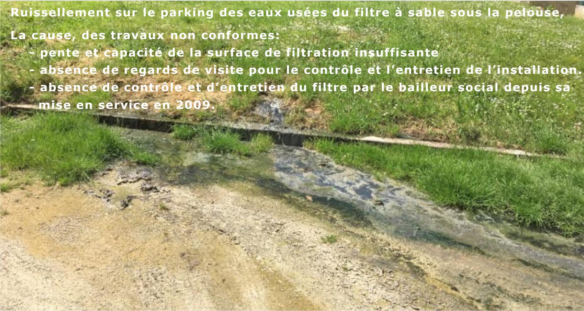
**Des épisodes récurrents de l'écoulement, avec les odeurs, des eaux usées de l'assainissement des logements dans la rue de la mairie, pour se déverser dans le réseau d'eaux pluviales de la rue de la mairie et de la rue de la Fontaine, pour terminer dans le Rhodon, avec leurs odeurs nauséabondes émises par les regards de ces rues.**
