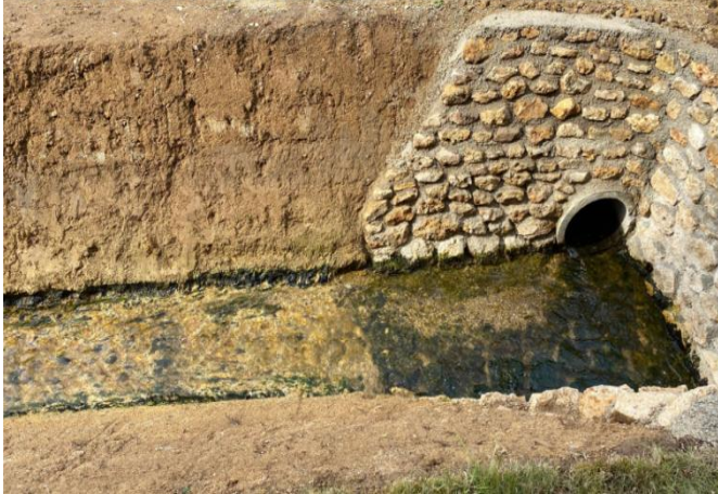
Buse de rejet des eaux épurées de la STEP du Mesnil-St-Denis dans le fossé crée en août et raccordé au Rhodon - Photo du 19.09.2021
